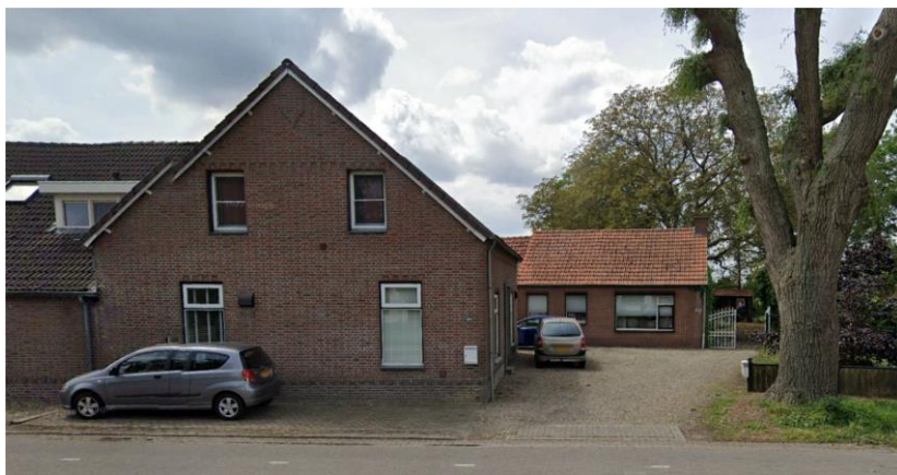
Figuur: aangezicht voorzijde (bron: Google Streetview) met links de woning Maaseikerweg 180 en rechtsachter de woning Maaseikerweg 182
