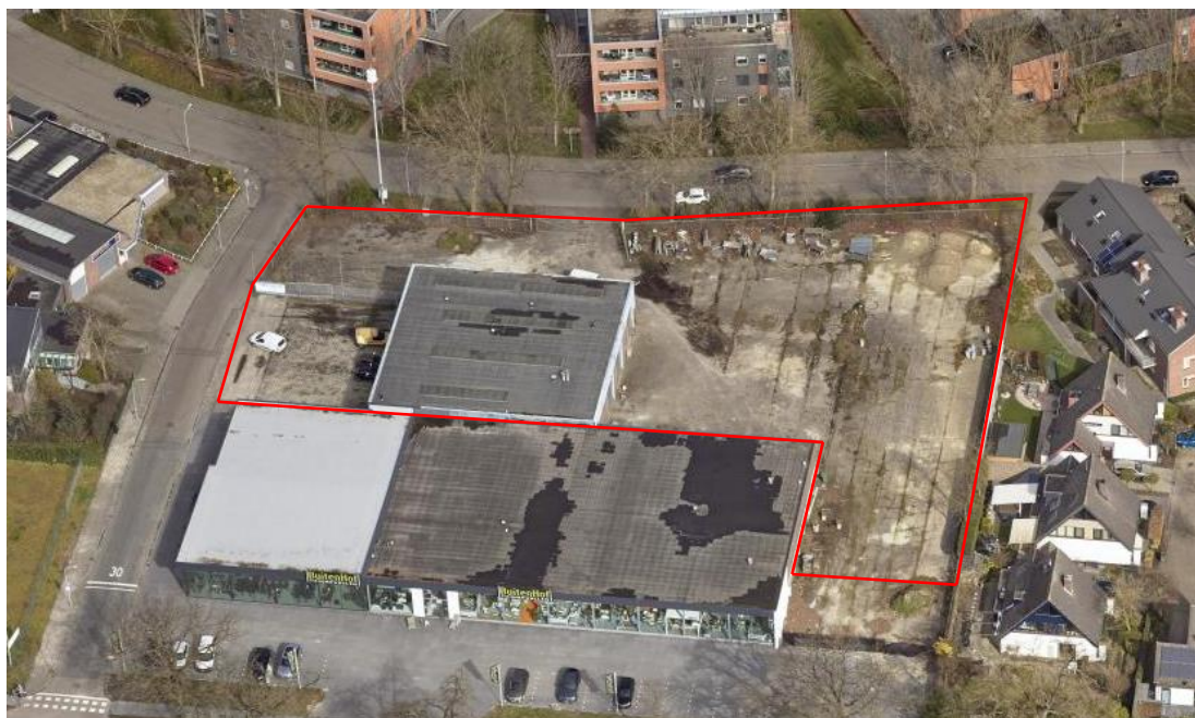
Figuur 1: de onderzoekslocatie.
