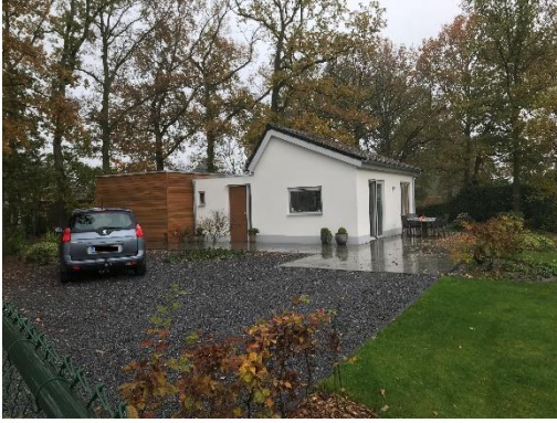
Mantelzorgwoning Breijbaan 58-Z1
