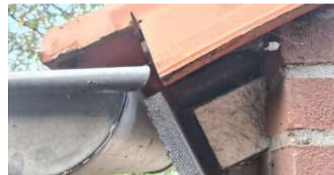
Figuur 11: Dakrand van het oostelijke deel van het bedrijfsgebouw
