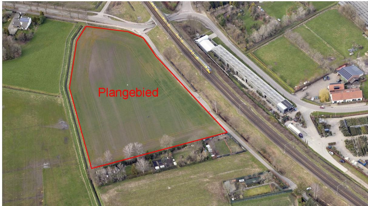
Foto bestaande situatie
