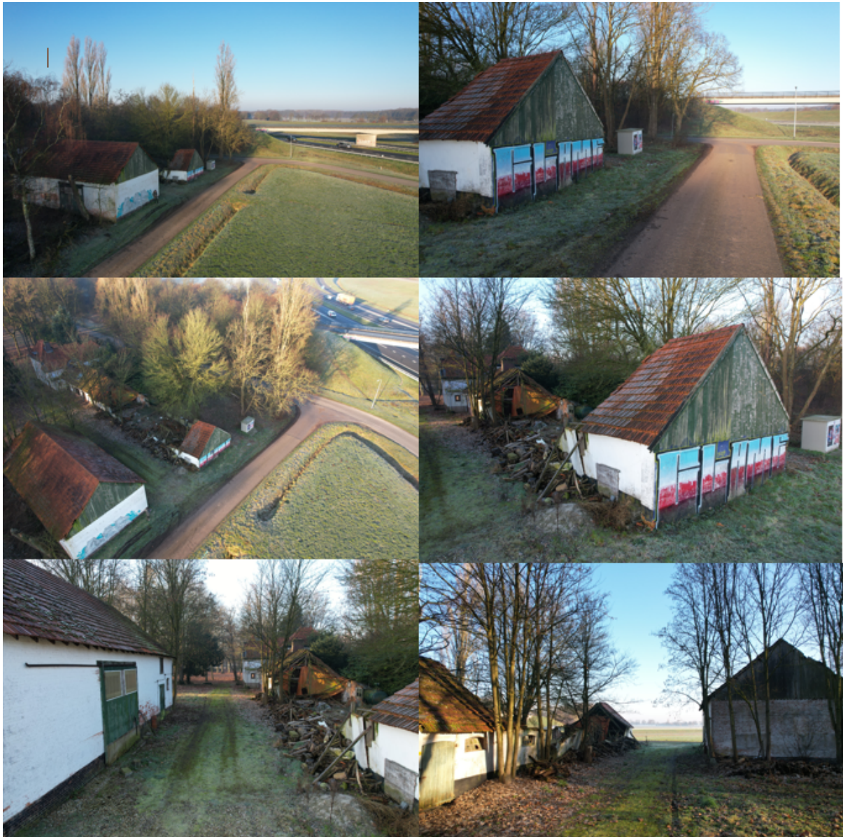
Impressie te slopen bebouwing bij de woning Stienestraat 63
