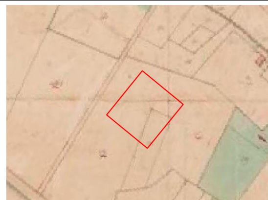
Situatie 1811 (bron: Beeldbank RCE)
