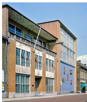
Oorspronkelijke montage aan de gevel in de Stationsstraat
