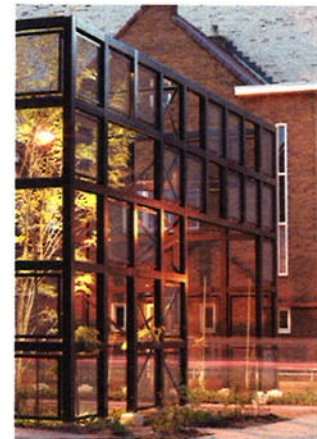
Referentiebeeld project 'Esthetisering van de Krimp' (Bureau Verbeek). Stalen constructie.
