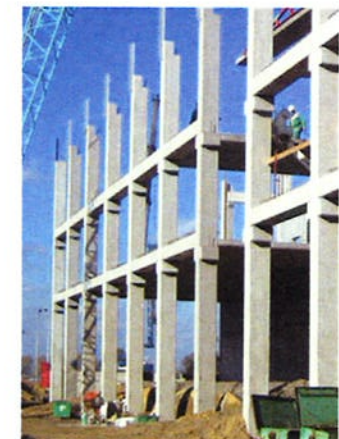
Referentiebeeld betonnen (prefab) skeletbouw.
