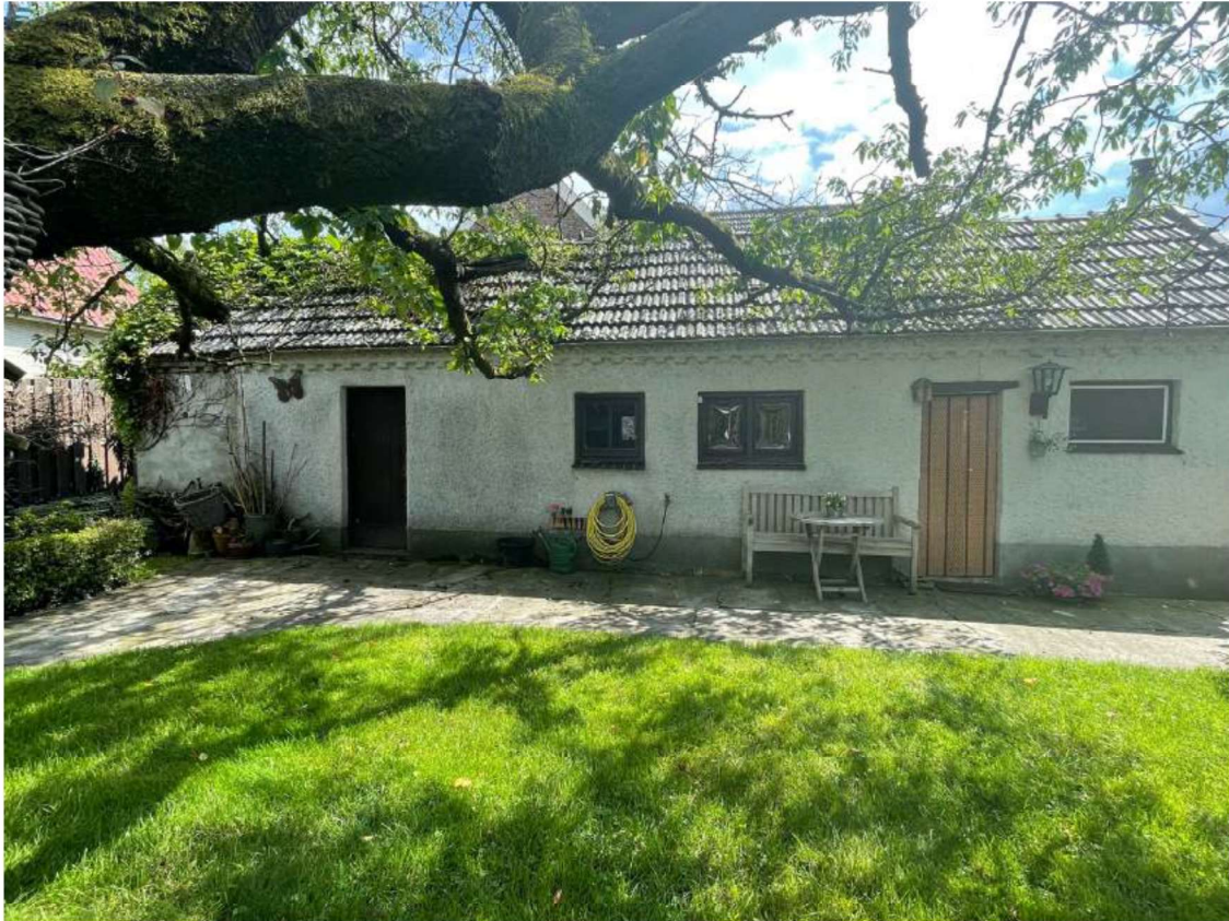
Foto 24 De achtergevel van het bijgebouw, gezien richting het zuiden. Gemaakt door: Klement Rentmeesters (2021)
