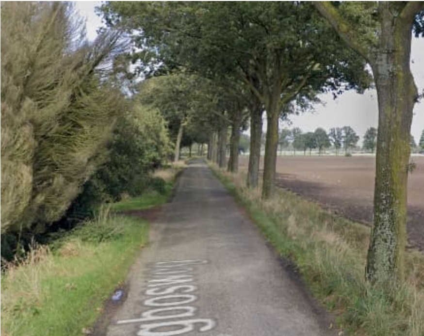
Afb. Hoogbosweg Rooien bomen, verbreden hoofdrijbaan, grasbetonstenen en fietssuggestiestroken.
