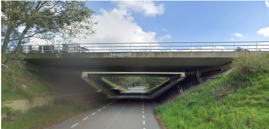
Afb. 20 Tunnel onder A2 in Eindhovenseweg (Noord-Brabant) nabij spoorlijn
