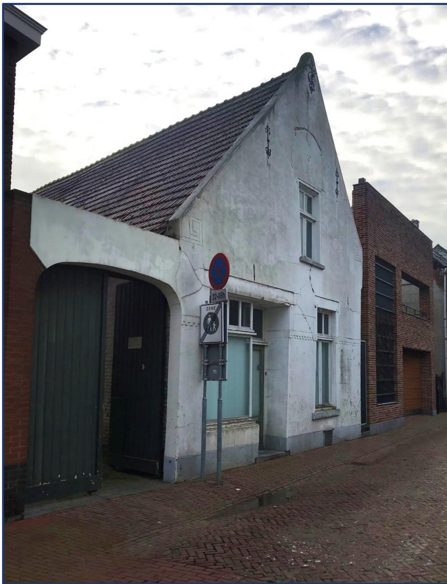
Figuur 2: Huidige situatie – voorgevel boerderij.
