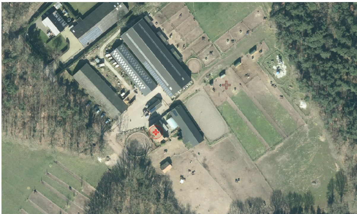
Afdruk luchtfoto Heihuisweg 5
