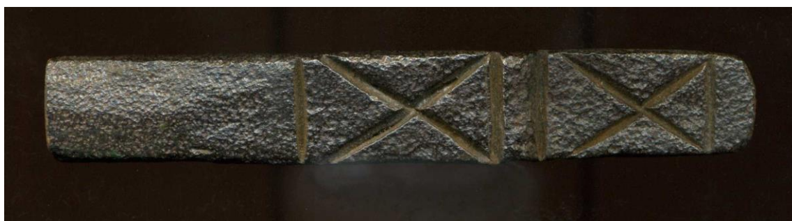
Fig. 13. Eiken ankerbalk met korbelen en telmerken, gedateerd 1787. Afkomstig uit bakhuys ten zuiden van 'De Plucksackhof'. Tekening: Alfons Bruekers.
