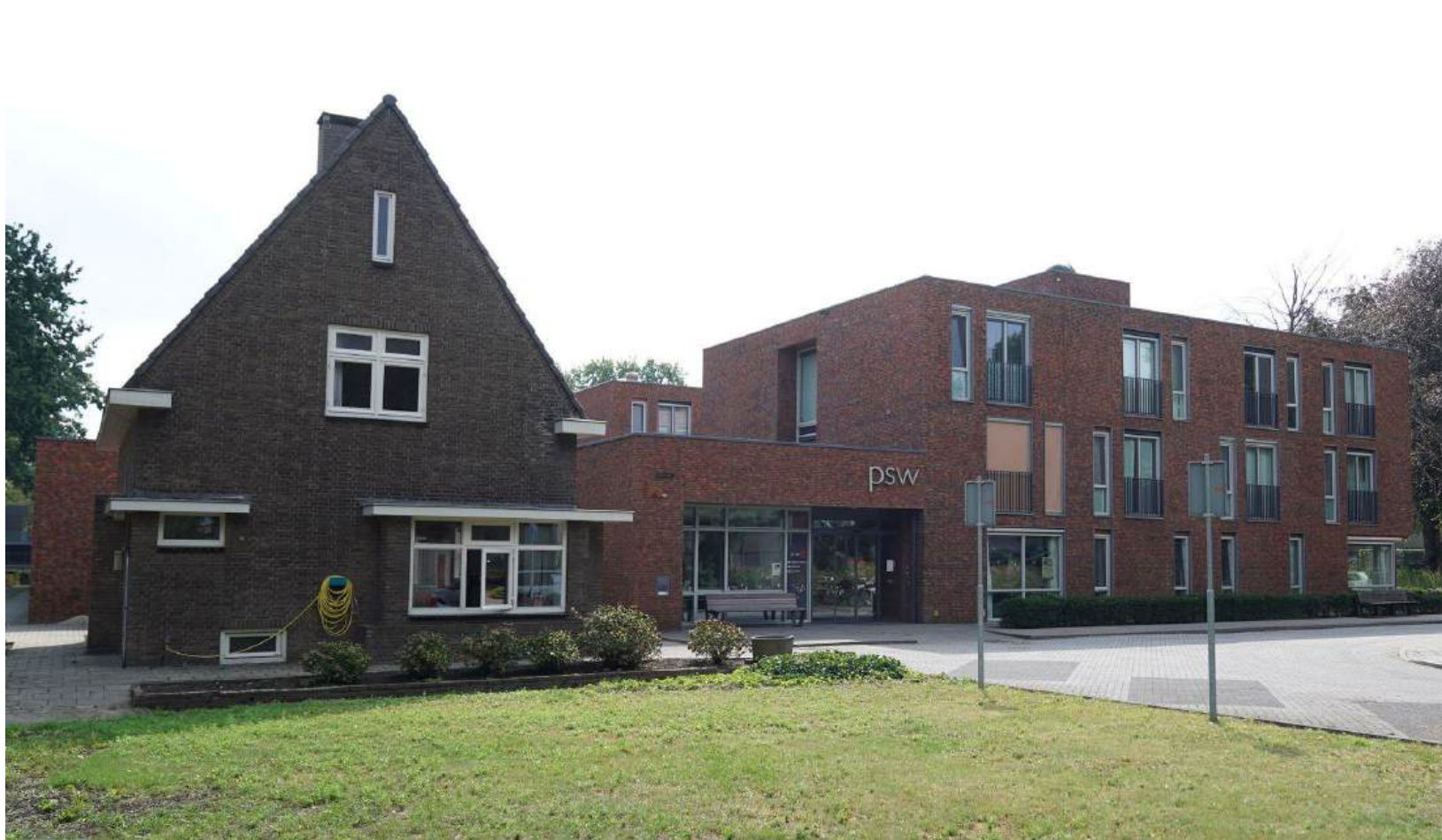
Bestaande woning met naastgelegen PSW gebouw
