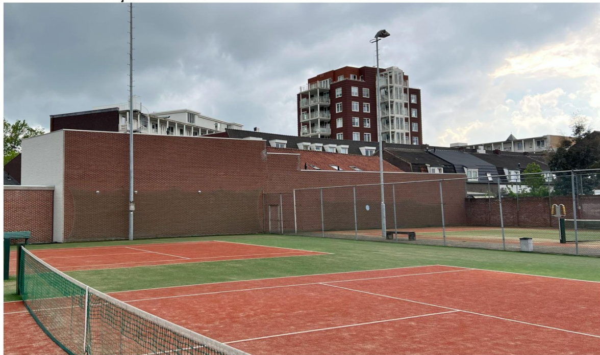
Dichte achtergevel aan de zijde van de Boermansstraat
