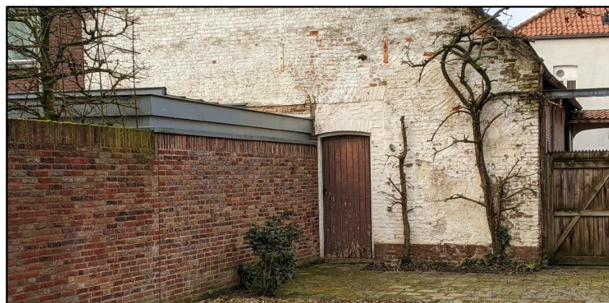
Figuur 3: Huidige situatie – achtergevel boerderij.
