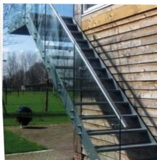
Zomers dakterras te bereiken via buitentrapp
