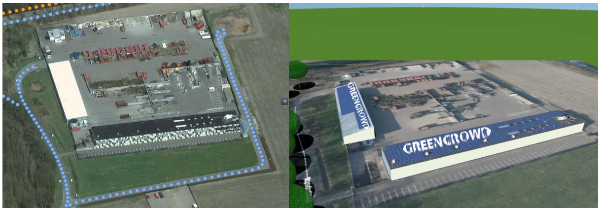
Afbeelding: luchtfoto gemeentewerf (links) en PV-Sol-intekening rechts door Greencrowd.
