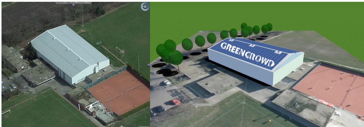
Afbeelding: luchtfoto sporthal op den Das (links) en PV-Sol-intekening rechts door Greencrowd.
