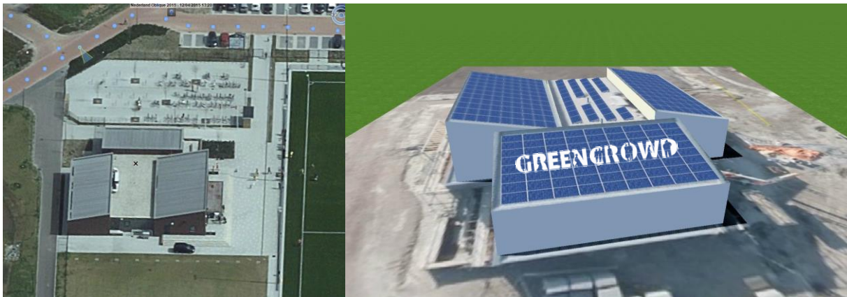
Afbeelding: luchtfoto DESM panden (links) en PV-Sol-intekening rechts door Greencrowd.
