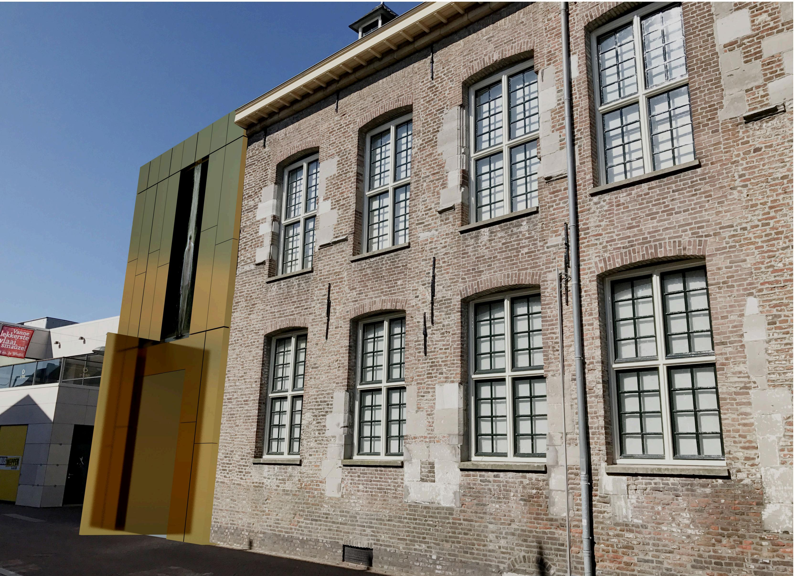
De messing gevelbekleding biedt de mogelijkheid om de achterbouw te isoleren, aangezien hier de kantoren en vergaderruimte zijn.
