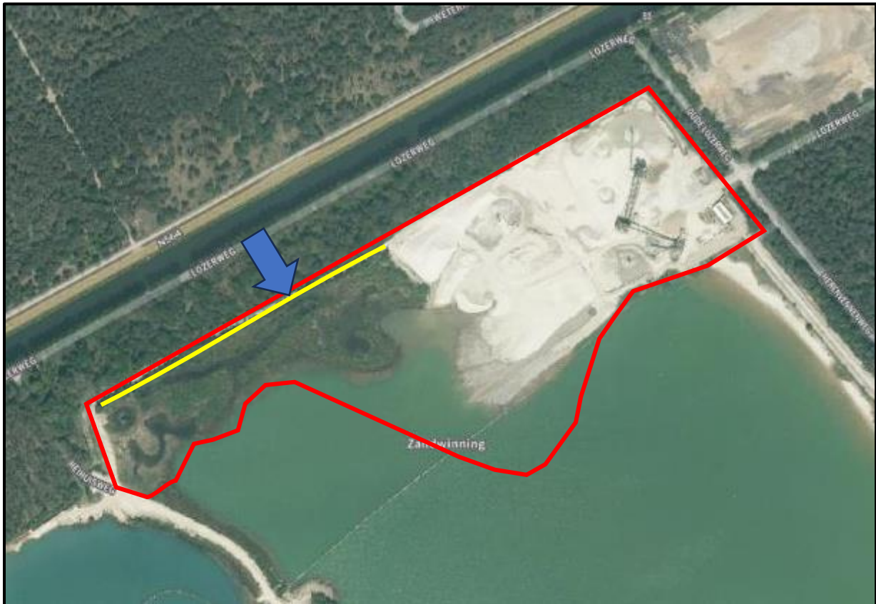
Figuur 2.3 Huidige situatie Noordelijke kweloever. De blauwe pijl geeft de richting van de kwelstromen vanuit de Zuid-Willemsvaart aan. Ter plaatse van de gele lijn bevindt zich de steilrand, waar aan de voet hiervan kwel uittreedt.
