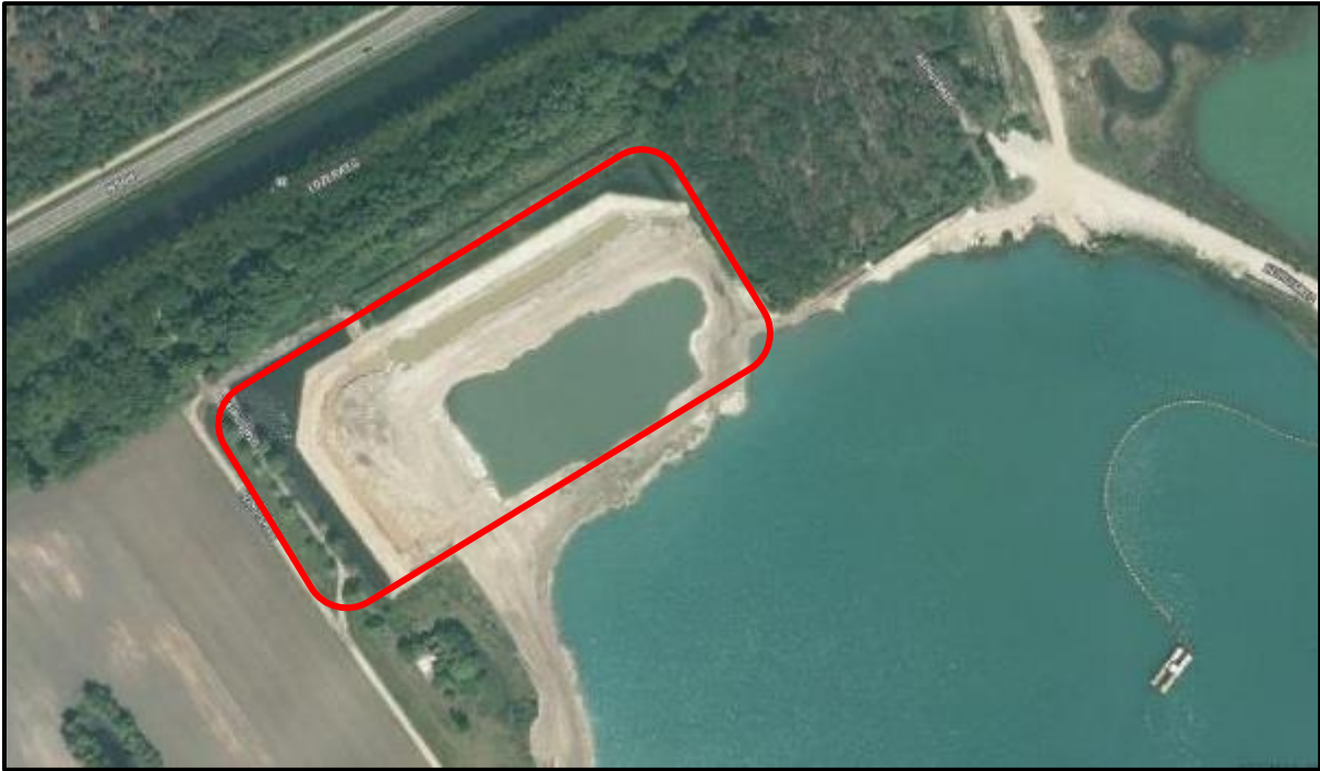
Figuur 2.5 Weergave van de situatie van het Zuidelijke kweloever gezien vanuit de lucht. De rode lijn is de begrenzing van het deelgebied.
