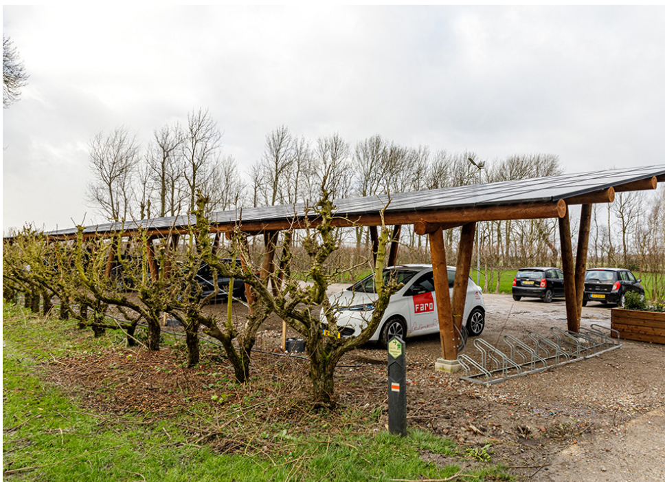
Afb. 79. Door slim materiaalgebruik kan ook de geconcentreerde parkeervoorziening een groene en zachte uitraling krijgen. Daarnaast biedt zo'n voorziening kansen voor een collectief dak met zonnepanelen.
