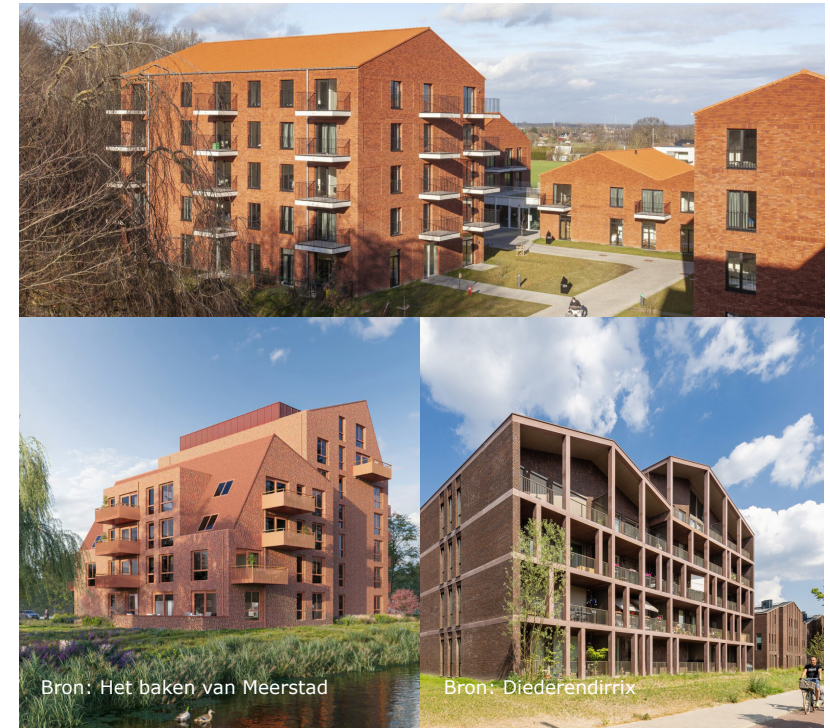
Afb. 92. Hogere bebouwing rondom het hart van Hushovervelden.
