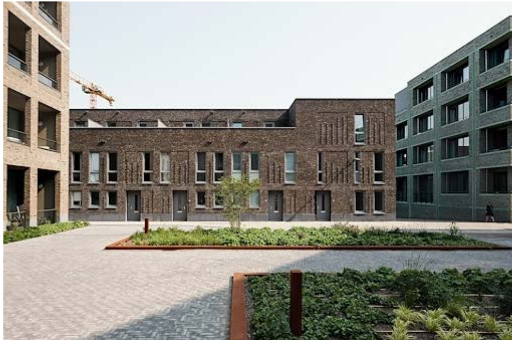
Ensemble van grondgebonden en appartementen woningen
