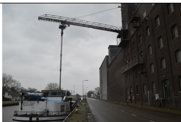
De silo's en gebouwen van Unicorn Grain Specialties BV zijn nog volumineuzer van die van Nukamel en staan ook langs het kanaal aan dezelfde zijde, maar dan meer naar het westen. Het oudste gedeelte is Rijksmonument
