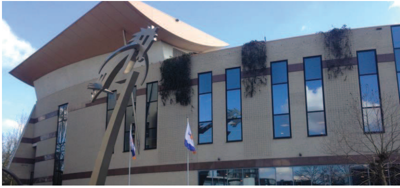
Foto: vergroening Kasteelplein 2
