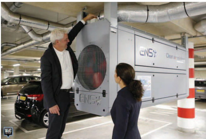
Foto: oplevering luchtfilterinstallatie Centrumgarage
