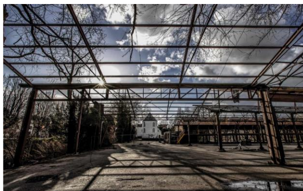
Foto: houthandel is verhuisd, asbest platen zijn verwijderd
