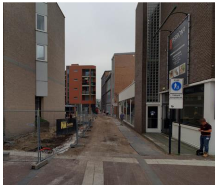
Foto: juni 2019, werk in uitvoering
