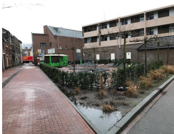
Foto: fietsenstalling na herinrichting
