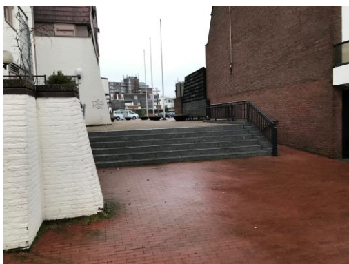
Foto: verbrede doorgang van Hegstraat naar parkeerdek
