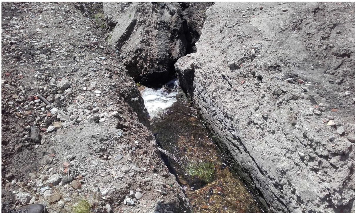
Afbeelding 2. Via deze geul stroomt ongezuiverd water vanuit het retentiebekken direct de Leukerbeek in. Het helofytenfilter wordt omzeilt.
