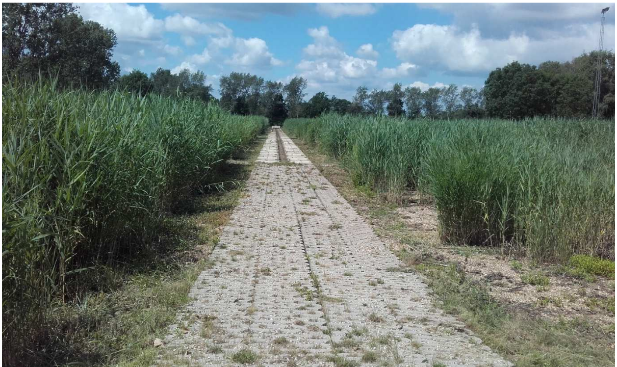
Afbeelding 6. Het helofytenfilter staat droog. De pomp staat uit. Aan beide kanten zou het drassig moeten zijn maar er is tot op een centimeter of vijf diepte geen water te vinden.
