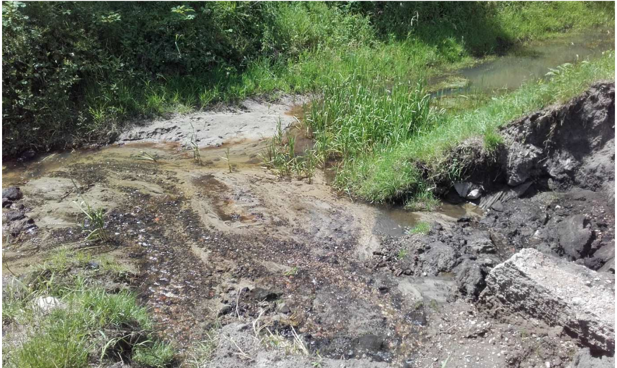
Afbeelding 3. Het ongezuiverde water stroomt direct de Leukerbeek in. Door de hevige regenval is er sprake van flinke grondafslag en verzakking. Water komende vanuit de wijk Graswinkel (rechts) wordt geblokkeerd.
